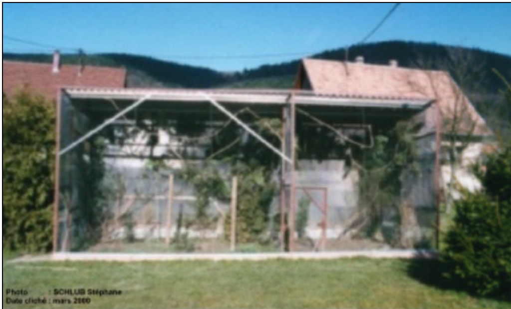
Photo 01 : Vue d'ensemble de la volière en mars 2000, non sécurisée contre les prédateurs. - des thuyas sur le côté protègent du soleil de l'après-midi, mais permettent aux martres de grimper sur le toit !
