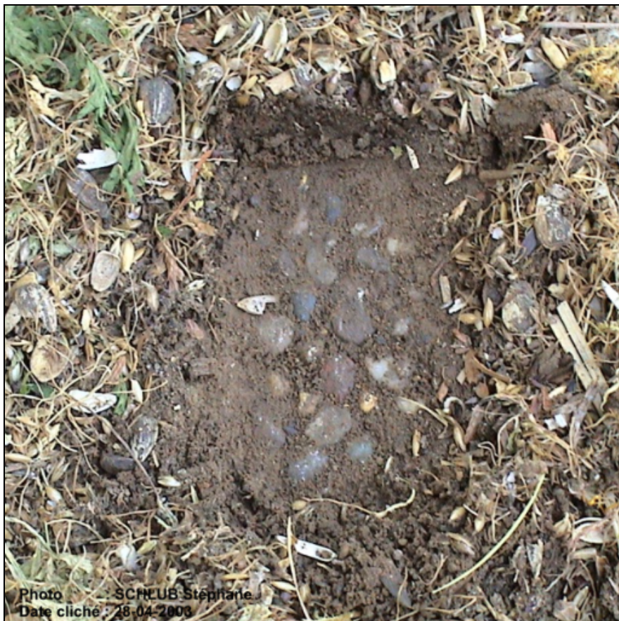
Photo 02 : Protection contre les intrusions venant du sous-sol. - une chape de dalles en béton, recouverte de quelques centimètres de terre, sécurise le sol de la volière.
